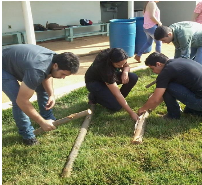
Figura 1: Mourões de eucalipto sendo descascados com bastões roliços de madeira.
